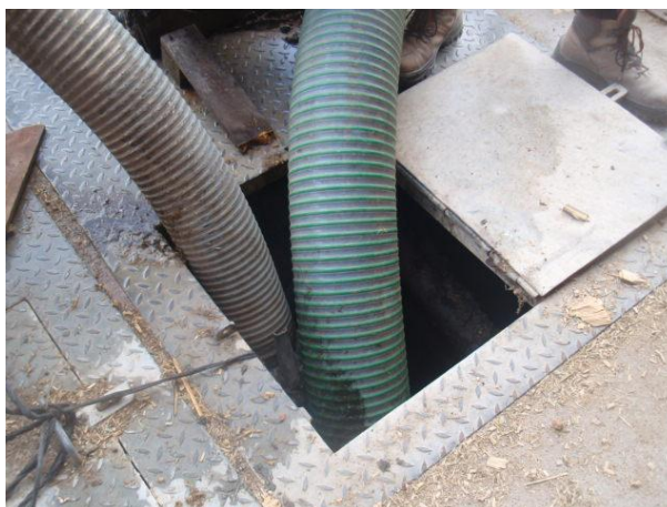
FOTOGRAFIA 7: LAGOA DE RETENÇÃO – EXTRACÇÃO DO EFLUENTE EXISTENTE NA LAGOA DE RETENÇÃO NO PAVILHÃO DAS VACAS LEITEIRAS
