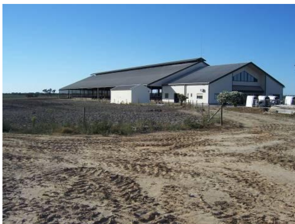
FOTOGRAFIA 33: VISTA GERAL DA ÁREA EDIFICADA
