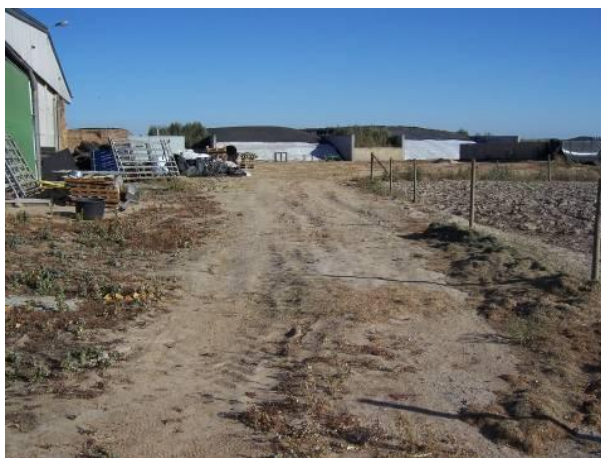
FOTOGRAFIA 32: ÁREA DE CONSTRUÇÃO DO SILO ONDE FOI REALIZADA A PROSPECÇÃO
